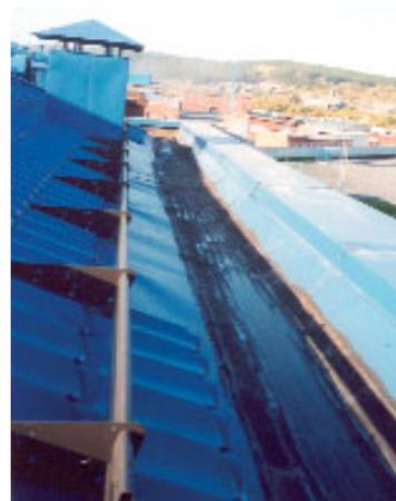
На крышах с желобами настенного типа обычно сам желоб выполняет функцию снегоотбойника (если имеет достаточно прочную конструкцию). В этом случае необходима защита нагревательного кабеля путем закрывания его листами металла, аналогичными материалу кровли.
