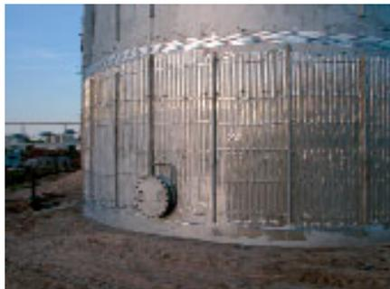
Нагревательный кабель должен быть равномерно уложен на всей поверхности резервуара.
