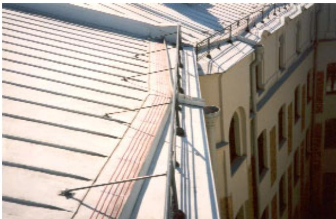
Применение кабельных систем отопления для очистки водостоков и кромок крыш ото льда является самым сложным, как для расчетов и проектирования, так и для монтажа и эксплуатации.
