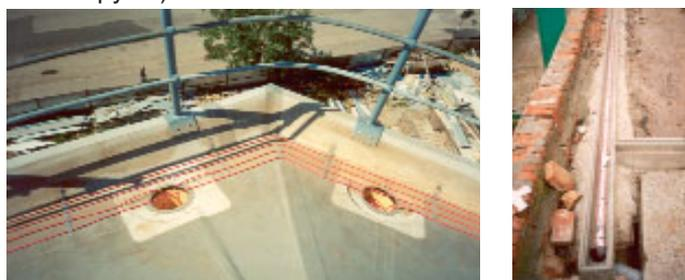
В случае, если водосточные трубы уходят в ливневую канализацию, сопровождающий обогрев необходим до точки промерзания грунта в данной местности. Также может потребоваться дополнительный обогрев ливневых колодцев и утепление их крышек.
