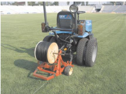
Расстояние между нитками кабеля зависит от его погонной мощности и установленной мощности на 1 м<sup>2</sup>. Эта величина лежит в пределах 20–40 см. Поверхность грунта практически не повреждается и готова к использованию спустя 10–15 дней после установки. Нагревательные кабели устанавливают на 20–30 см ниже поверхности, чтобы избежать их повреждения при использовании спортивных снарядов с острыми наконечниками и прочими инструментами тех. служб.
