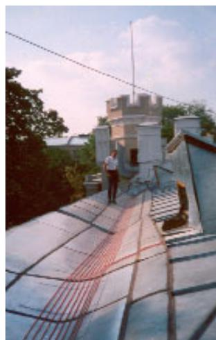
Крепление кабеля производят с помощью монтажной ленты **Devifast™** аналогично креплению в желобах.
