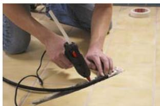
Трубка термодатчика (Ø 9 – 16 мм) должна быть заглушена со стороны датчика для предотвращения попадания внутрь раствора при заливке стяжки.
